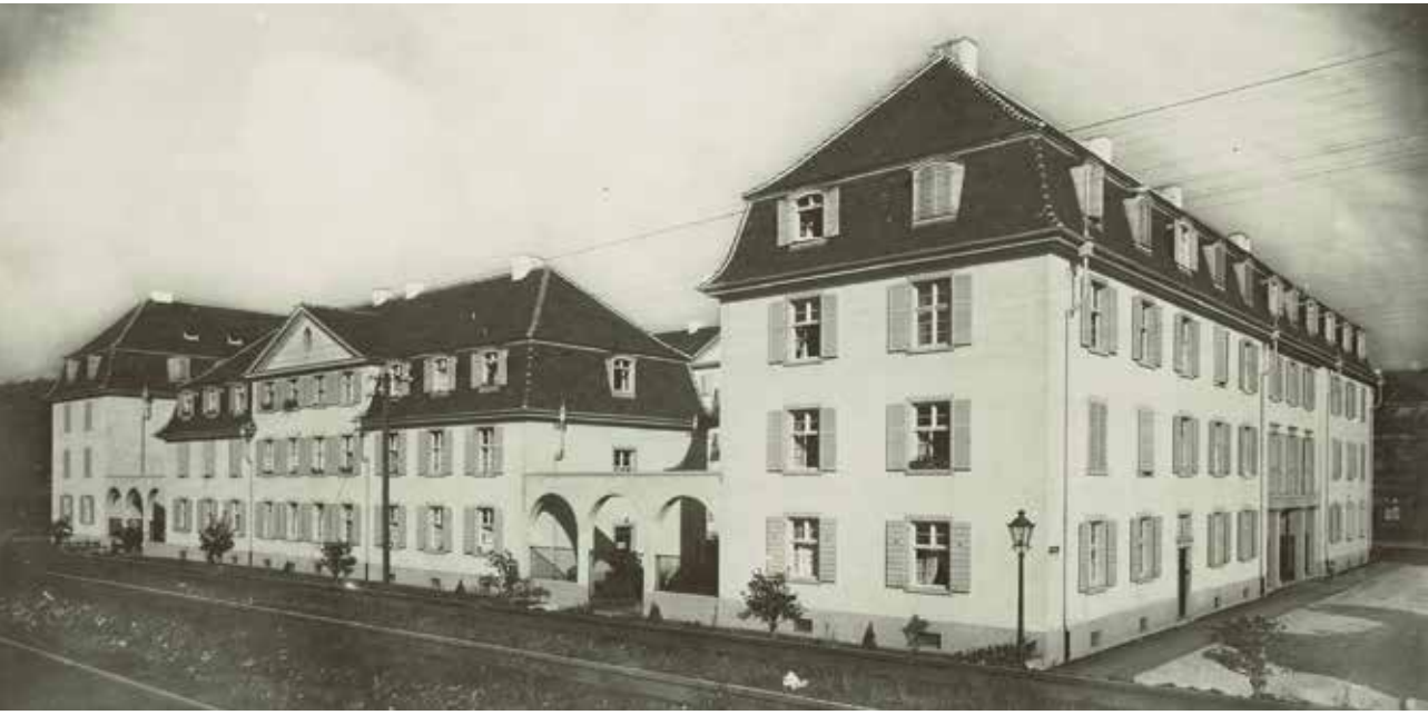
Gesamtansicht des Heimbau-Ensembles von der Bahnseite
