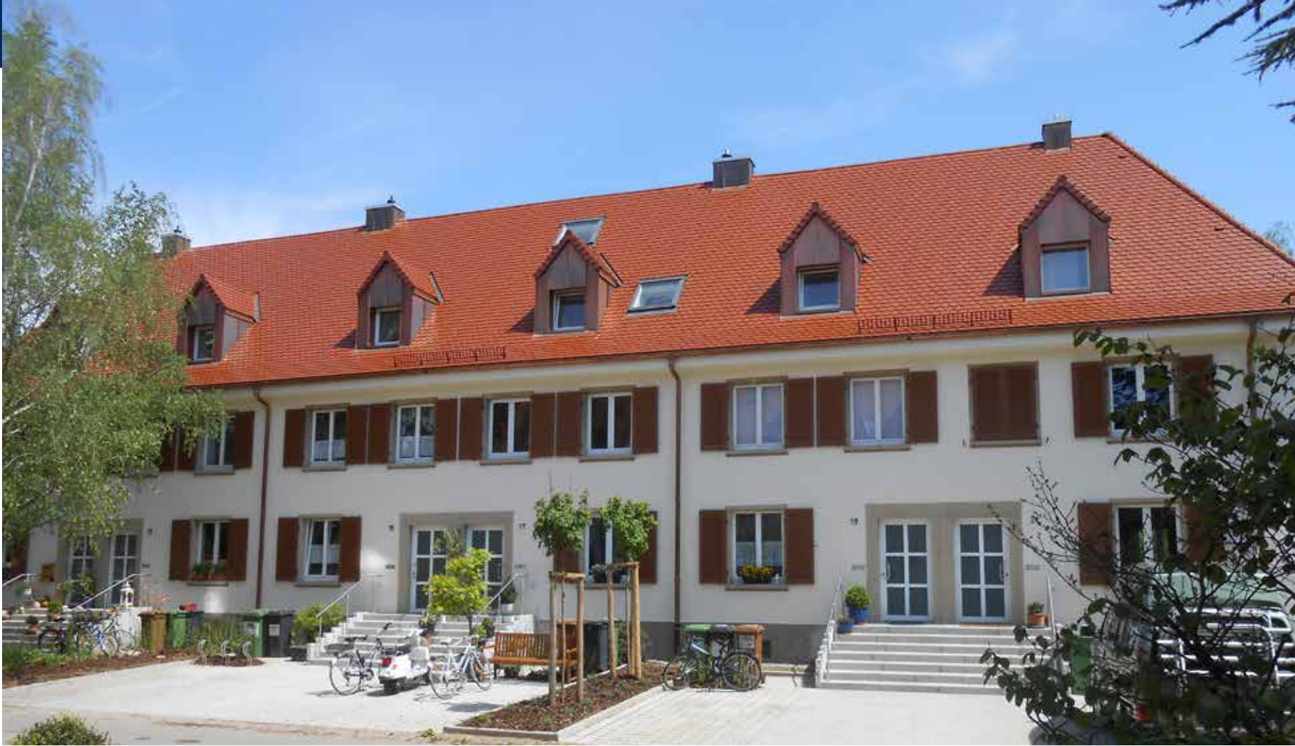
2012 wurden die Einfamilienhäuser in der Dimmlerstraße im Stadtteil Waldsee aufwändig saniert.
