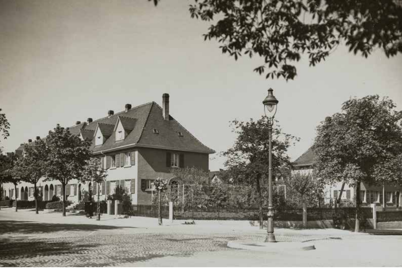
Blick von Norden auf die erste Reihenhaussiedlung in der Stefan-Meier-Straße 109-127 (Freiburg-Herdern)
