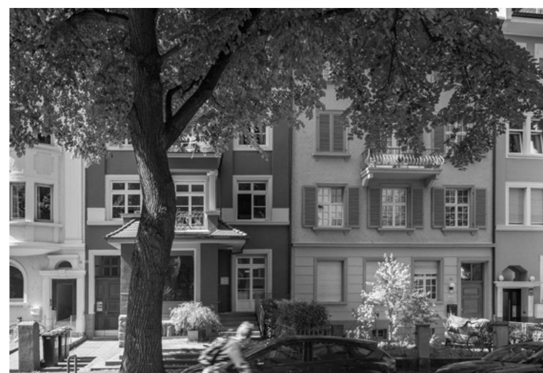
2010 denkmalpflegerisch hochwertig instandgesetzt und gemäß Denkmalschutzaufgaben energetisch saniert - die 1923 erbauten Wohnhäuser in der Sautierstraße in Freiburg-Herdern.
