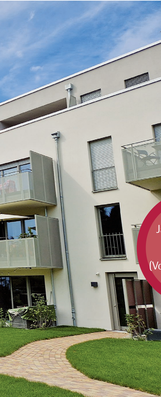
Das neue Mehrfamilienhaus-Ensemble am Kreisel Durlacher Straße / Steigenhohlstraße in Ettlingen wurde nach etwas mehr als zweijähriger Bauzeit fertiggestellt. Im April dieses Jahres wurden die 52 Wohnungen bezogen. Das klimafreundliche Effizienzhaus 55 verbraucht pro Quadratmeter und Jahr nur 7 Kilogramm CO 2 .
